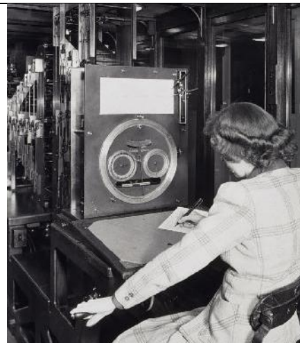
Tidevandsforudsigelser produceres. Bemærk håndtaget – og se Kelvins trisse-apparat!
