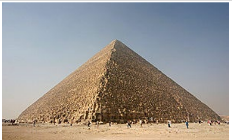
Da Cheopsypyramiden blev bygget, var den 147 m høj, og den var i ca. 4000 år verdens højeste bygning. Den havde dengang en glat overflade lavet med hvide kalksten, men et voldsomt jordskælv i år 1300 løsnede disse kalksten og noget af det øverste af pyramiden, så den kom til at se ud, som vi nu ser den.
