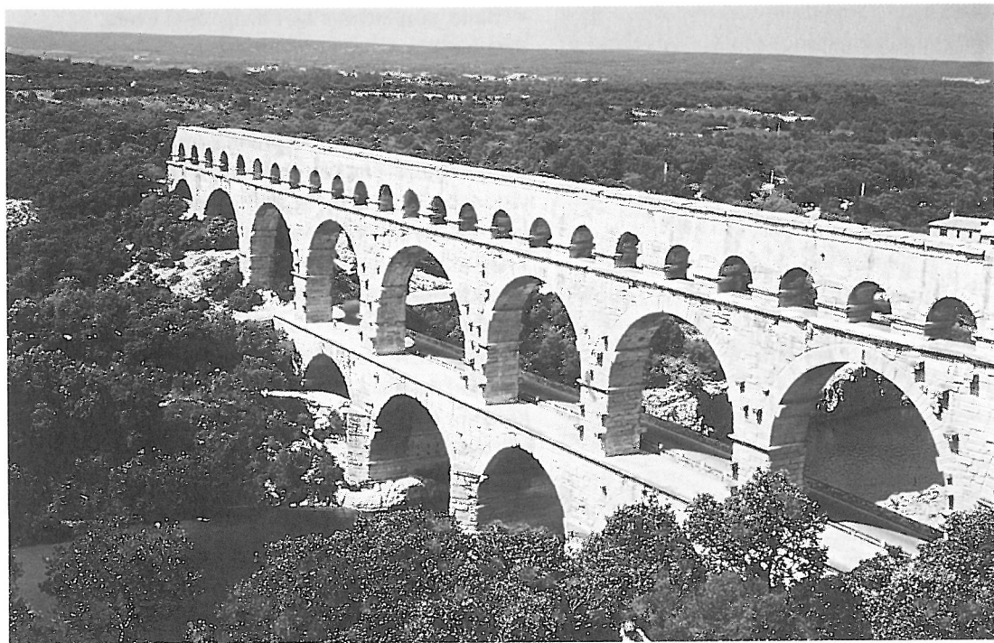
Den såkaldte Pont du Gard, aquaedukten, som førte vand ind til antikkens Nîmes. Her føres ledningen over floden Gard. Vandet løb i den rende, som kan ses helt for oven. Den nedre del har senere tider udvidet en smule, så den kunne fungere som bro.
